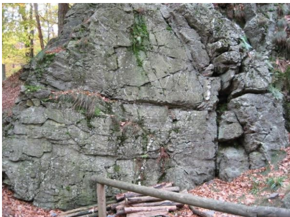
Figuur 5: Scheuren in een kwartsietbed.
